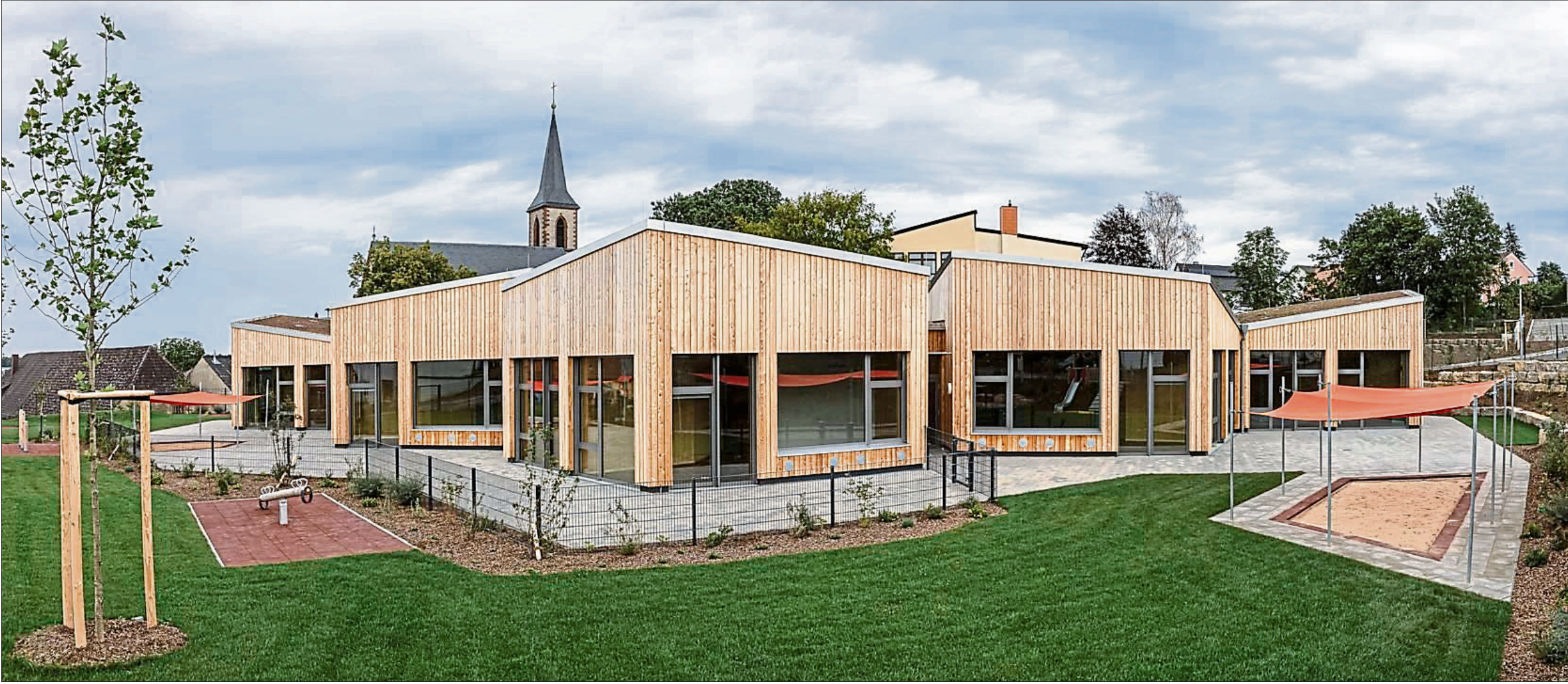
Die Kindertagesstätte in Waldbrunn wurde in Holzbauweise erstellt.
